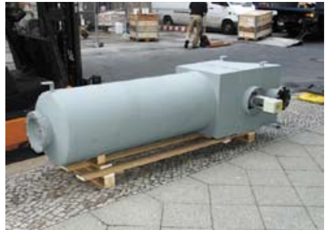
Rußfilter-Schalldämpfer-Kombination CRP-SB2-AP für 300 kVA mit einer Systemdämpfung von 50 dB(A)
